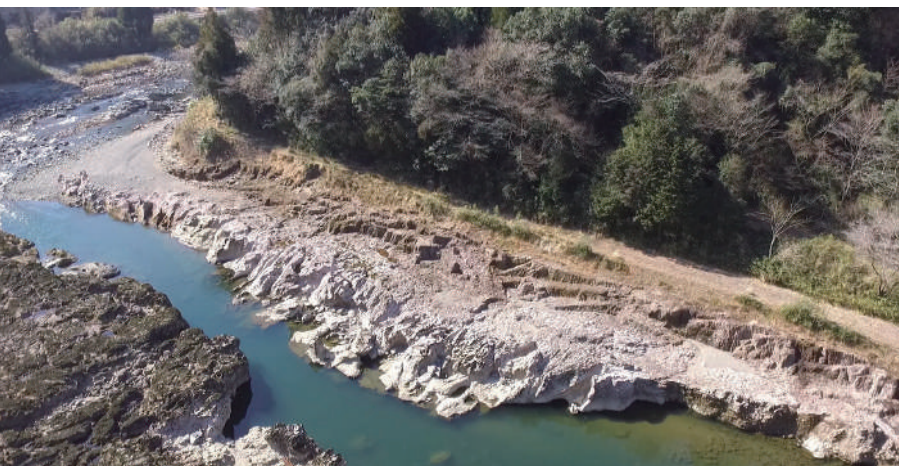
柿坂地区のICT工法 自然の岩に近づけた掘削
